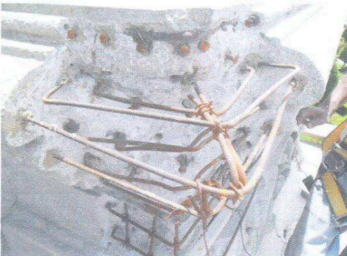
Proceso de la integración del acero con Sikadur-31N al Balcón Presidencial
