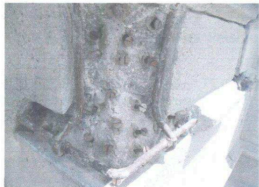
Proceso de la integración del acero con Sikadur-31N al Balcón Presidencial
