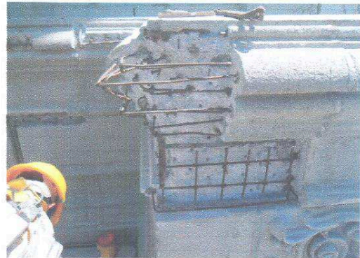
Otra pieza de considerable tamaño a la cual se le esta integración el acero
