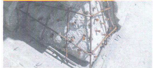
Trabajos de integración de acero en piezas del Balcón Presidencial
